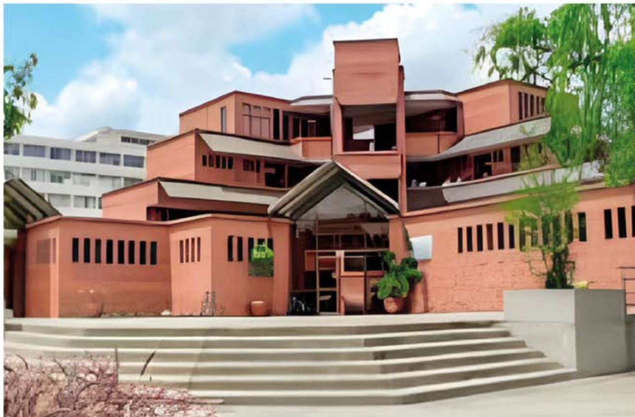
Edificio actual, moderno y funcional, de la Facultad de Odontología de la Universidad de Cuenca.
