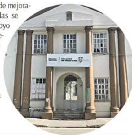
Fachada que fue de ingreso al antiguo Hospital "San Vicente de Paul". Ahora funciona el Centro de Salud "Nicanor Merchán" y en la parte posterior, el Museo de la Medicina del Azuay.
